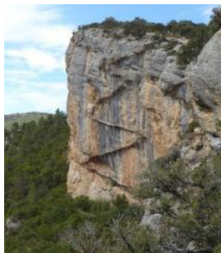
Passerelles de Montfalco
